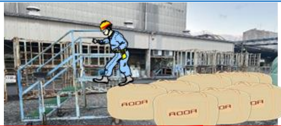
昇降架台が傾き危ないと感じ、昇降架台から飛び降りた →昇降架台の設置場所の安全を確認!
