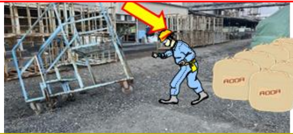
昇降架台が傾き危ないと感じ、昇降架台から飛び降りた →昇降架台の設置場所の安全を確認!
